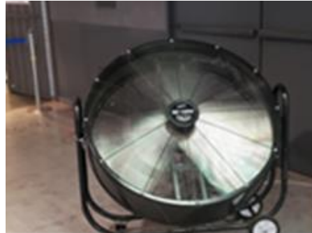
換気用ファンの設置
