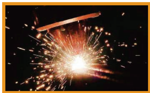
TLC施工の様子
