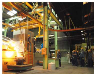
高周波るつぼ形誘導炉 〔富士電機(株)〕
