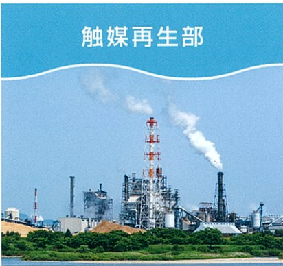
発電プラント脱硝触媒の 再生加工工事
