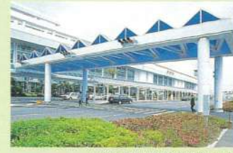
鹿児島空港歩道屋根工事
