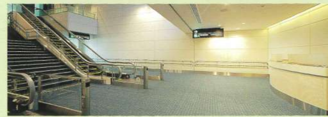
羽田第2ターミナル 内壁パネル
